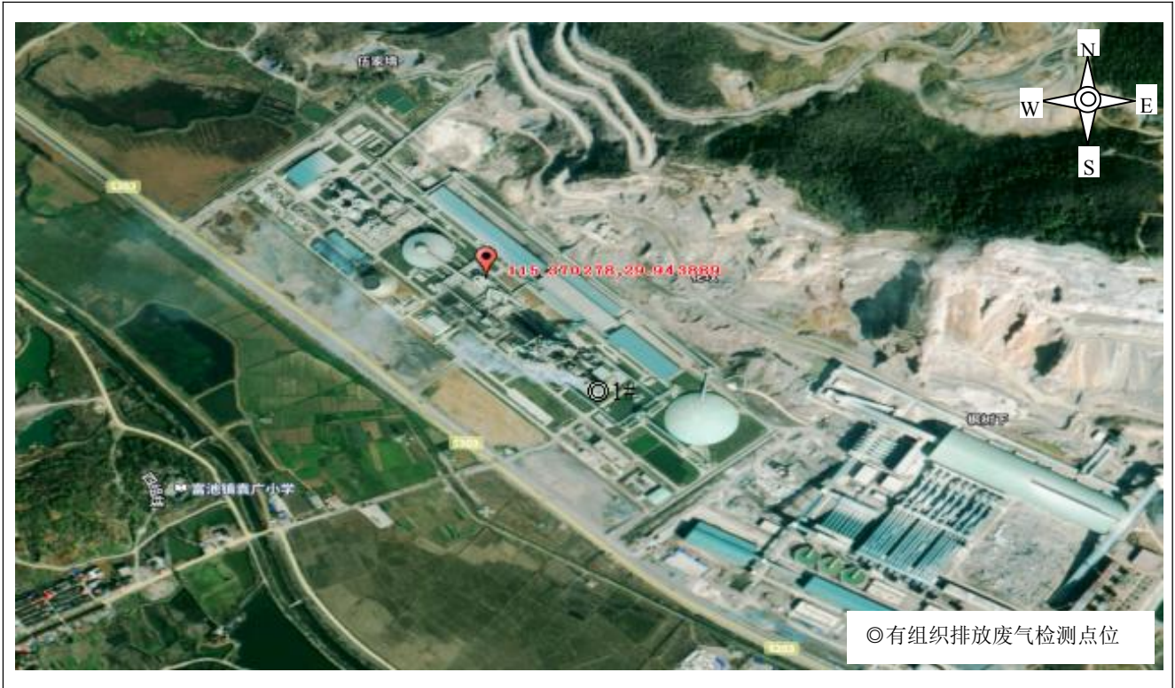
附图：现场检测照片
